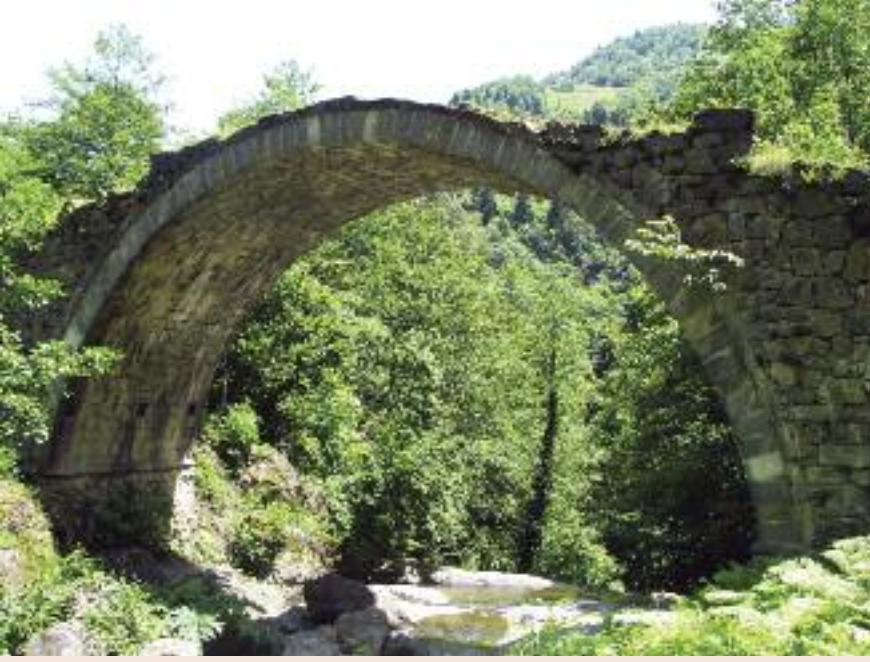
Tokmakardı Köprüsü - Güdün köyü (*)
